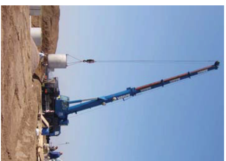
Abbildungen 22 bis 25: Einsetzen der Lysimeterbehälter am 01. April 2005
