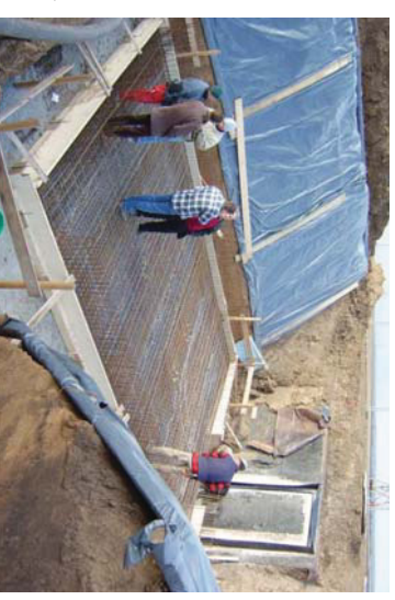
Abbildung 17: Bau der Lysimeterkeller: Baufortschritt am 19. Januar
